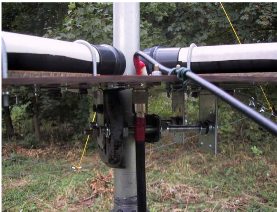
Obr. 10. Připojení koaxiálních kabelů k základové desce.
